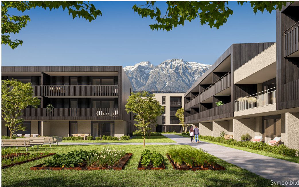
Wohnanlage in Volders 46 Eigentumswohnungen samt Tiefgarage
